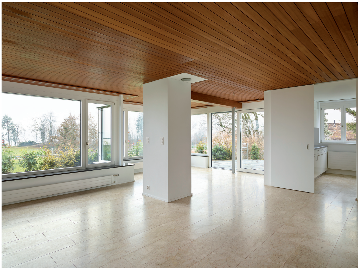
Wohnzimmer mit Blick in die Küche, fließender Raum um den freistehenden Kamin (Speicherofen folgt 2018) Die bestehende Täferdecke wurde örtlich ergänzt, der durchgehende Natursteinboden ist neu
