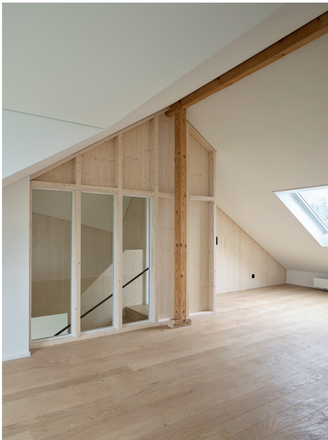
Atelierraum im Dachgeschoss mit der Erschliessung hinter der neuen Ständerwand
