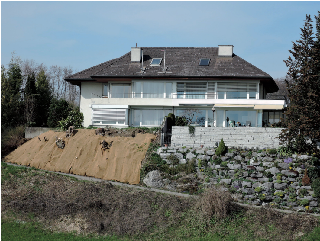
Linker Hausteil vor dem Umbau (nach Rodung und provisorischer Böschungssicherung)
