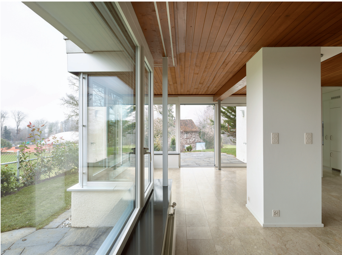
Die Fenster sind vor der Dämmung auf die alte Fassade montiert, der Ausdruck der Fassade bleibt erhalten, der Innenraum gewinnt durch die Fenstersimse
