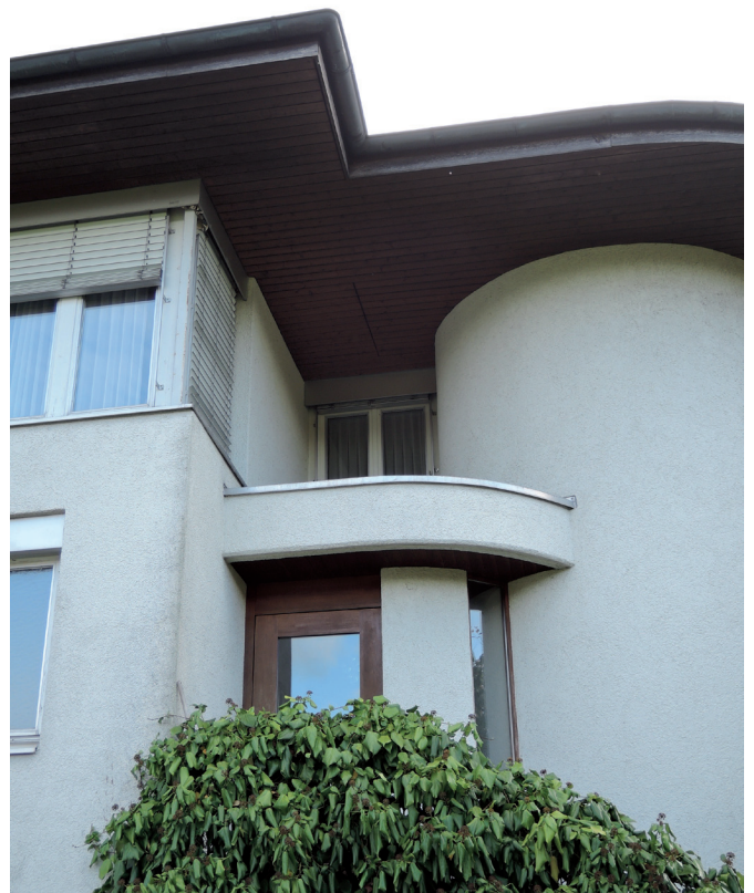
Eingangssituation volumetrisch verunklärt durch den 1977 ergänzten Windfang
