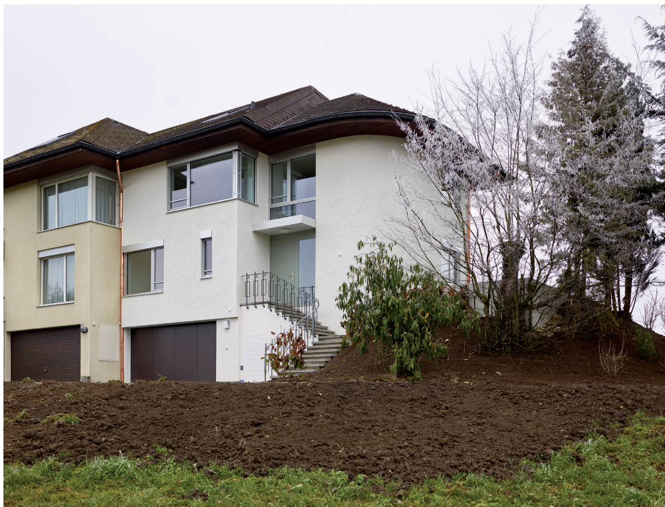
Nord­fas­sa­de mit der vo­lumetrisch be­ruhig­ten Ein­gangs­si­tu­a­tion über zwei Ge­schos­se. Ver­bin­dung der bei­den Häu­ser über Dach­un­ter­si­cht und Garagen­tor, Fas­sa­de in glei­chem Farb­ton aber we­ni­ger bunt
