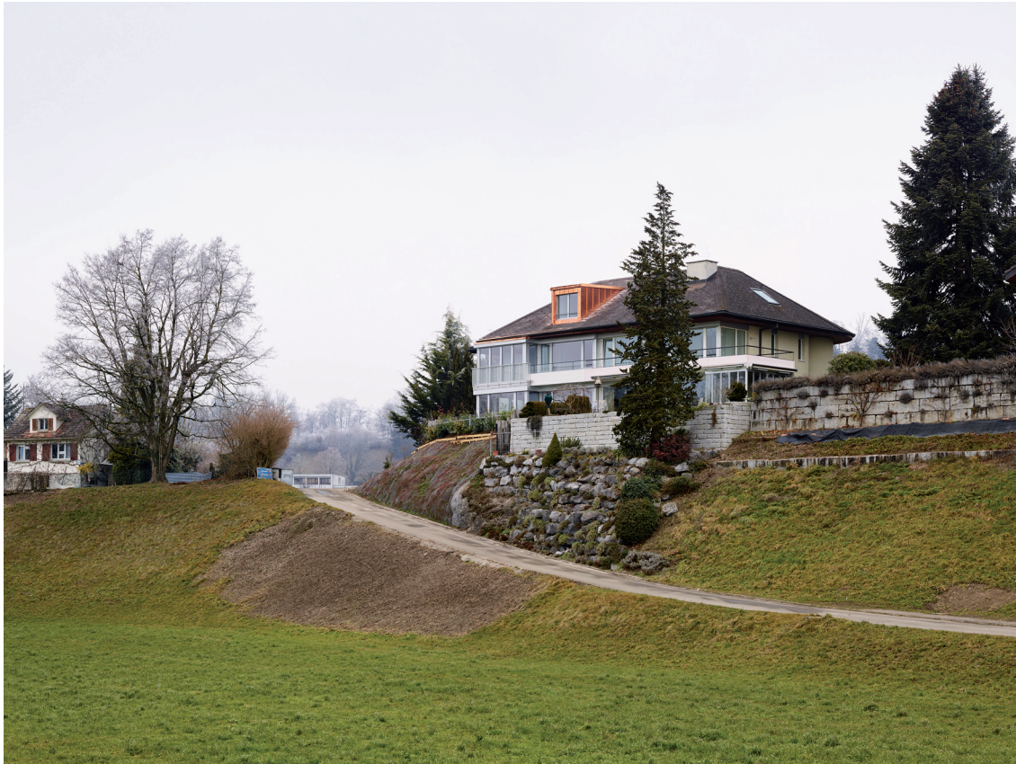
Südfassade des Doppel­ein­fa­milien­hauses mit der neuen Lukarne und der verglasten Gebäude­decke. Böschungssicherung ohne Stützmauer
