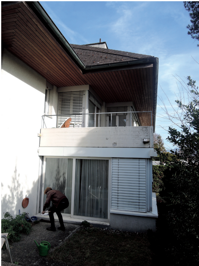
Balkon im OG. Offene Gebäudeecke vor Einbau des «Jahreszeitenzimmers»
