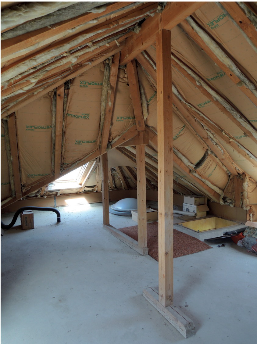
Dachraum mit Cupolux-Oblicht des ehemaligen Flachdachs
